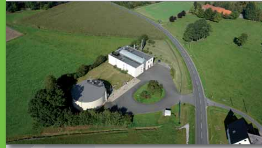
Die Sickerwasserkläranlage an der Lipplinger Straße wurde im November 1998 in Betrieb genommen
