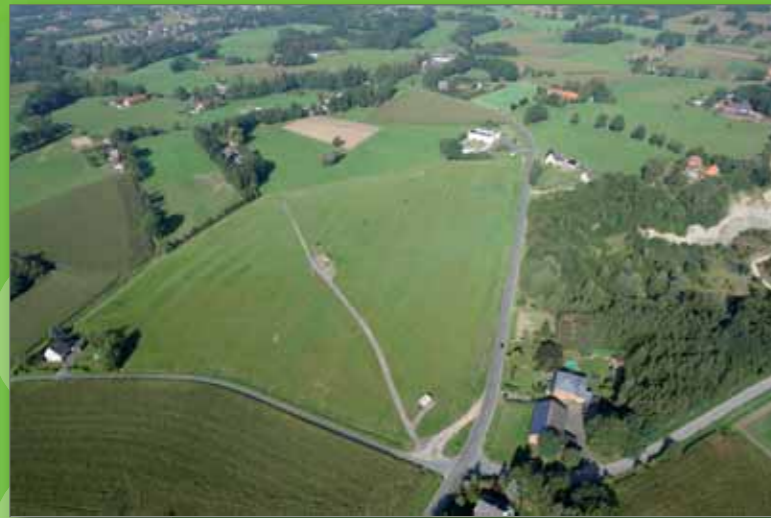
Die Deponie Westerwiehe I im Sommer 2008
