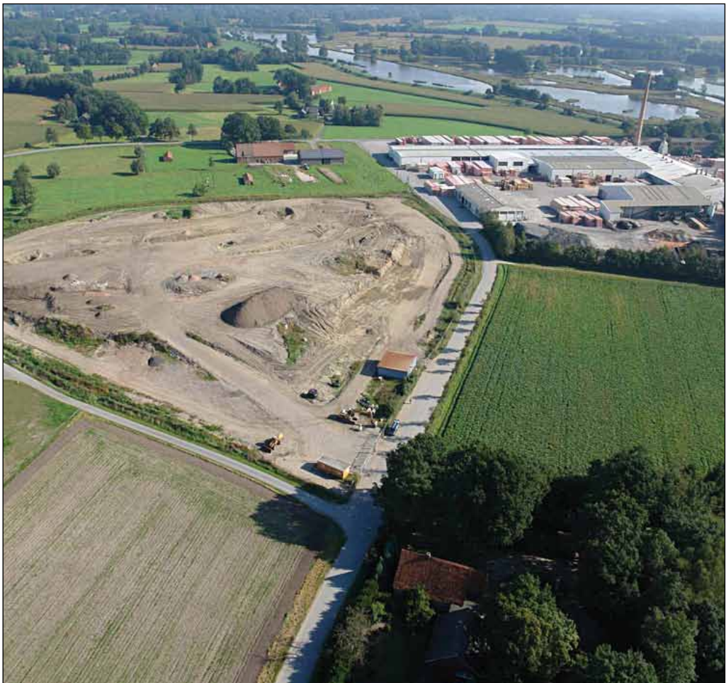
Bild 21: Die Arbeiten an der Oberflächenabdichtung und Rekultivierung der Deponie Westerwiehe II sind im Gange. Darunter: Hausmüll, rund 650.000 Kubikmeter.
