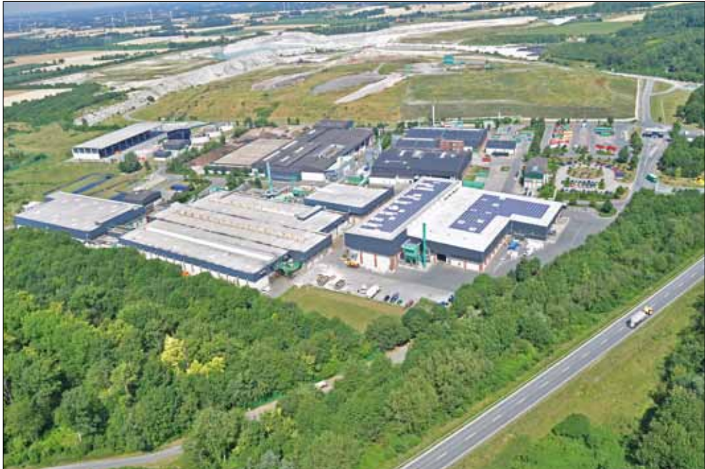
Bild 3: Das Entsorgungszentrum Ennigerloh aus der Vogelperspektive. Im Vordergrund die verschiedenen Abfallbehandlungsanlagen, im Hintergrund die Zentraldeponie, auf der nach der Behandlung nur noch rund 35 Gewichtsprozent des Restmülls abgelagert werden.
