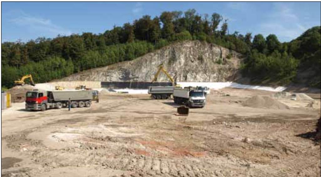
Bild 20: Die Bodendeponie Borgholzhausen erhält eine Basisabdichtung für die Deponieklasse I, darunter befindet sich Boden und Bauschutt der Deponieklasse 0.
