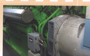
Gasmotor mit Generator
