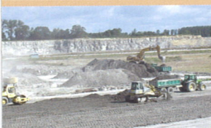
Aufbringung der geotechnischen Barriere
