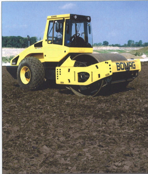
Mechanisch-biologisch vorbehandelte Abfälle werden auf der Zentraldeponie Ennigerloh eingebaut
