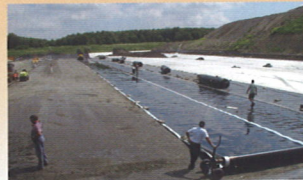
Verlegen der Kunststoffdichtungsbahn (KDB)
