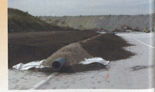
Drainageröhre in der Entwässerungsschicht
